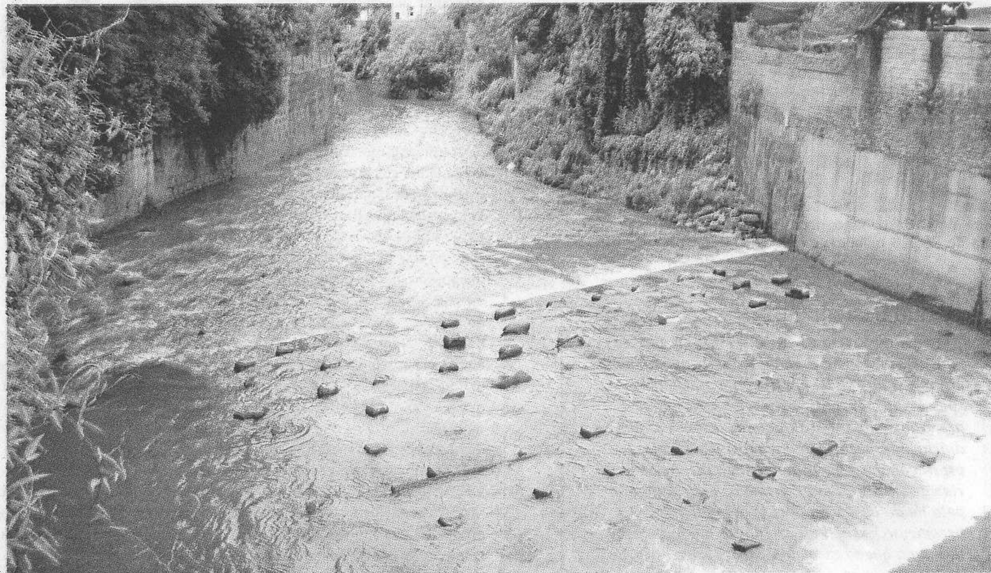
A rede coletora de esgoto de Passo Fundo possui apenas 33 km de extensão
